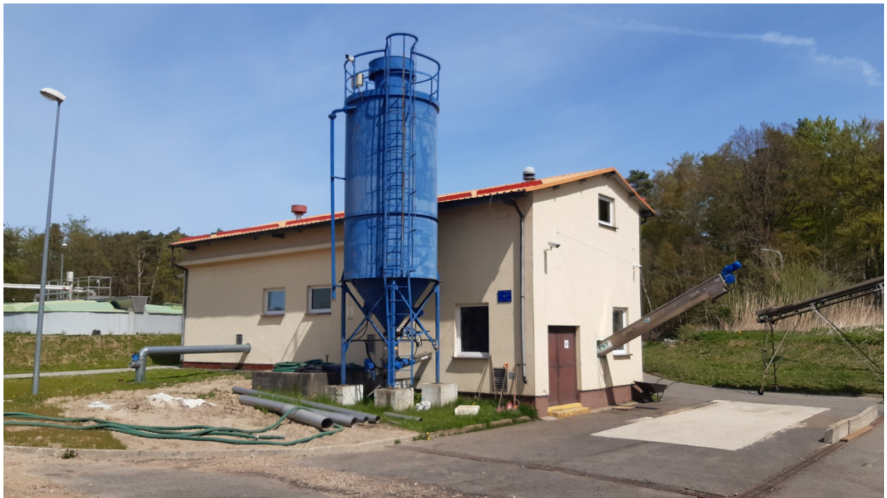
Zdjęcie nr 2 Widok z bliska silosu cylindrycznego konstrukcji stalowej
