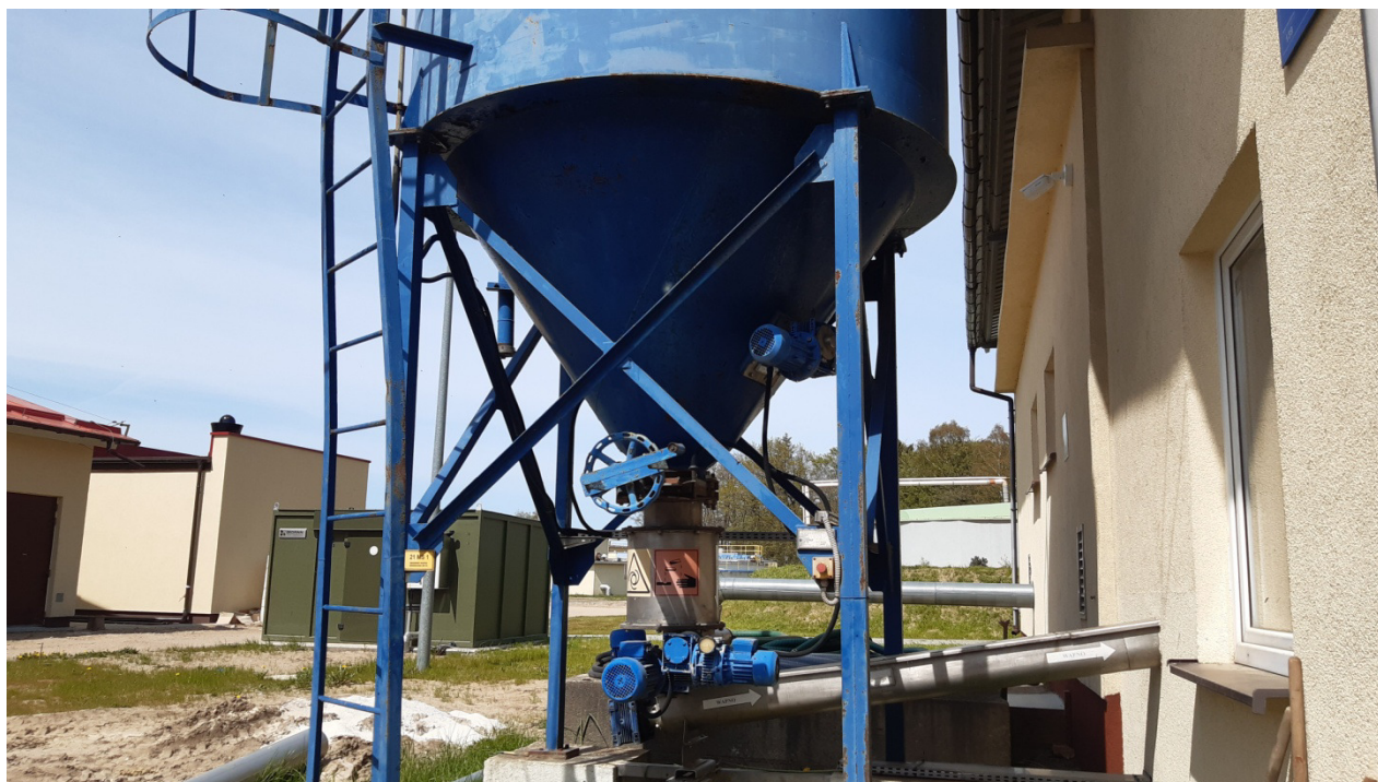
Zdjęcie nr 1 Widok boczny konstrukcji nośnej silosu cylindrycznego konstrukcji stalowej
